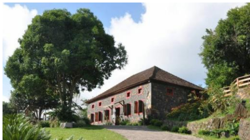
Caminhos de Pedra
